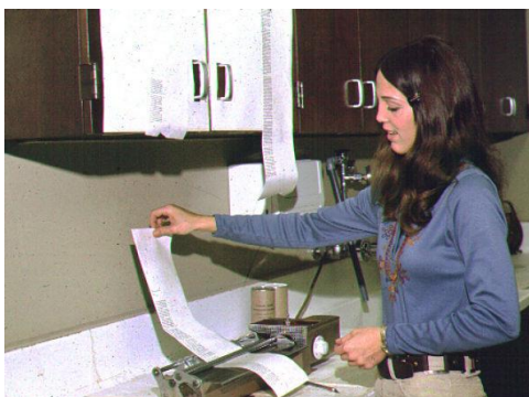
Figura 4. A fotocomposição era passada na máquina de cera pelo montador de página. 6
