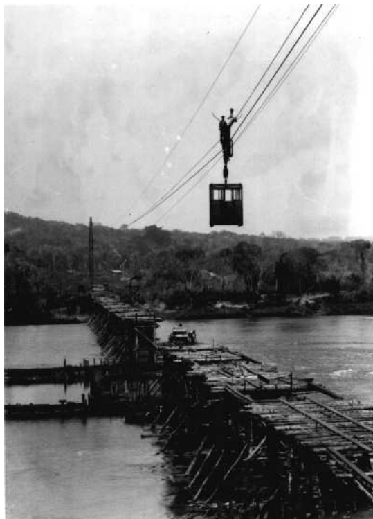
Figura 3 – Construção da ponte ferroviária sobre o rio Tibagi
