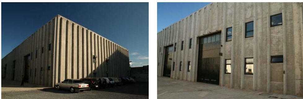
Figura 1 - Vistas externas do pavilhão industrial simulado.
