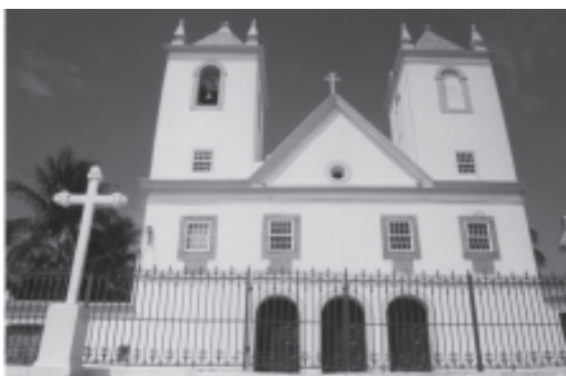
3 Fachada frontal da Ig. Santo Antônio da Barra - Salvador - Séc. XVII.
