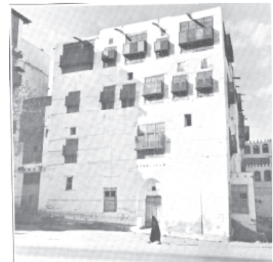
2 Edifício de adobe rebocado em Jedah / Arábia Saudita
