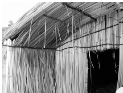
Detalhe da cobertura para o fechamento lateral. Whare Raupo, 2003.
