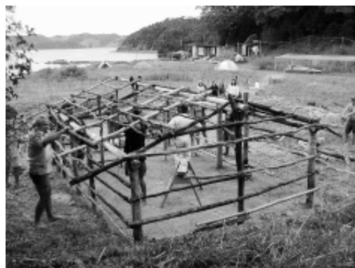
Construção da estrutura. Whare Raupo, 2003.
