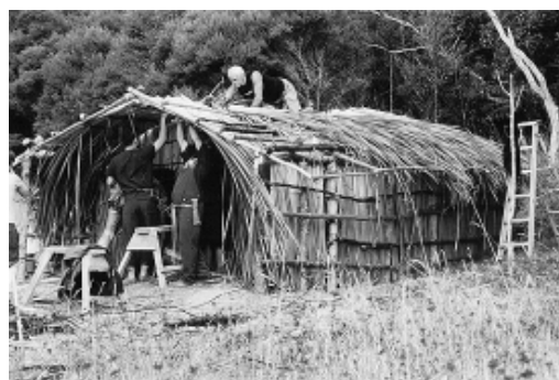
Colocação da cobertura. Whare Raupo, 2003.
