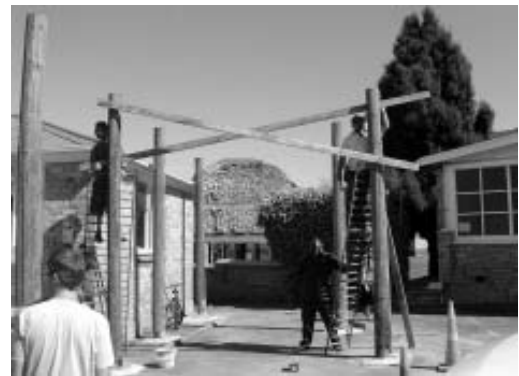
Construção da estrutura. Te Hononga, 2005.
