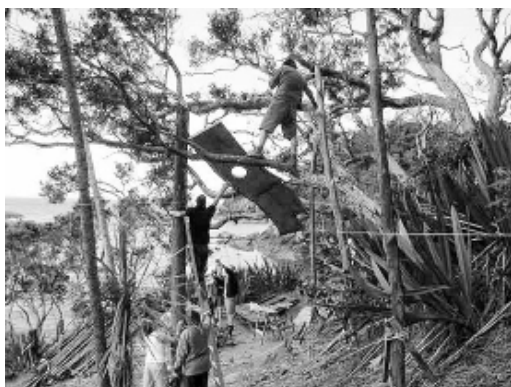
Construção da estrutura. Whare Raumati , 2002.
