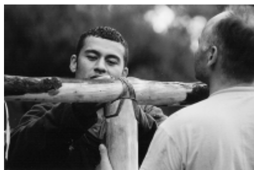
Detalhe da amarração da estrutura. Whare Raupo, 2003.
