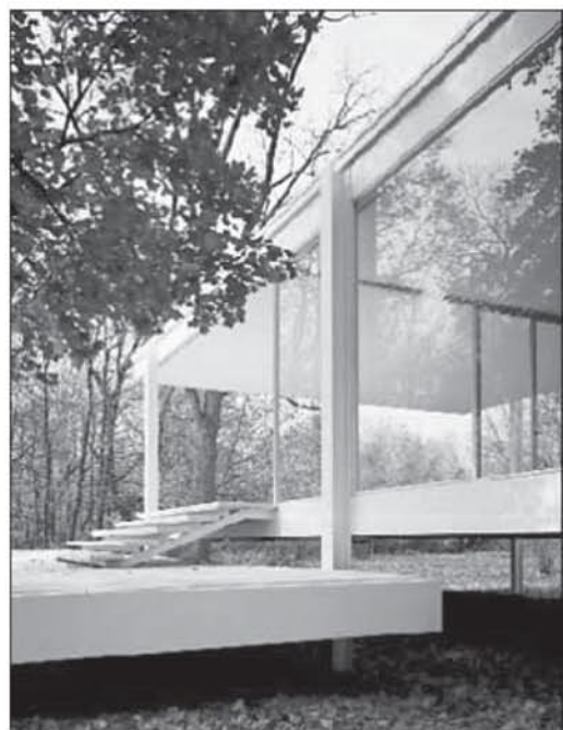
Mies van der Rohe - Farnsworth (estrutura externa)
