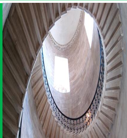
ESCADAS DE CONCRETO ENG HD 001
