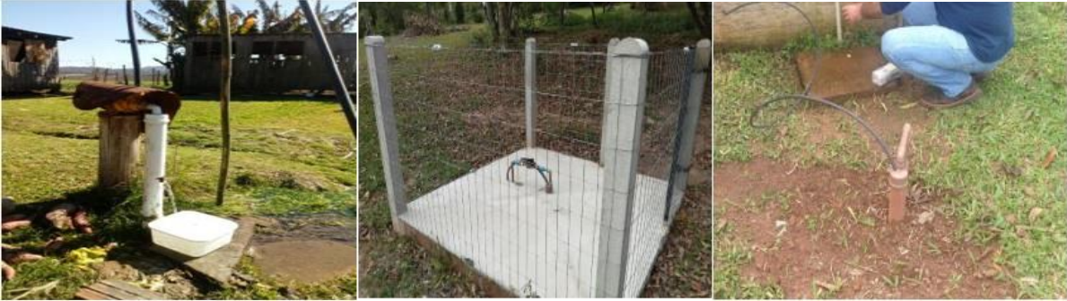
c) Poço Ponteira
