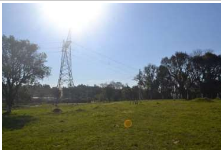
Figura 1.4-30 Linha de transmissão atual junto ao traçado definido para a Linha de Transmissão 230 kV Osório 3 - Gravataí 3 C1.
