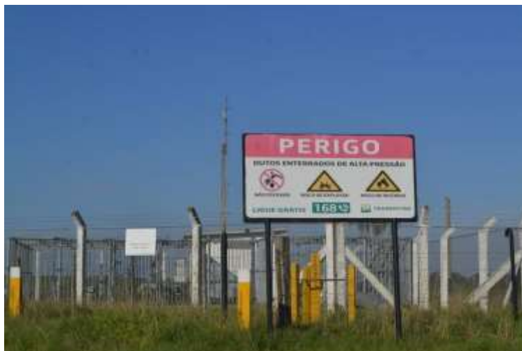
Figura 1.4-50 Passagem de dutos de gás nas propriedades locais.
