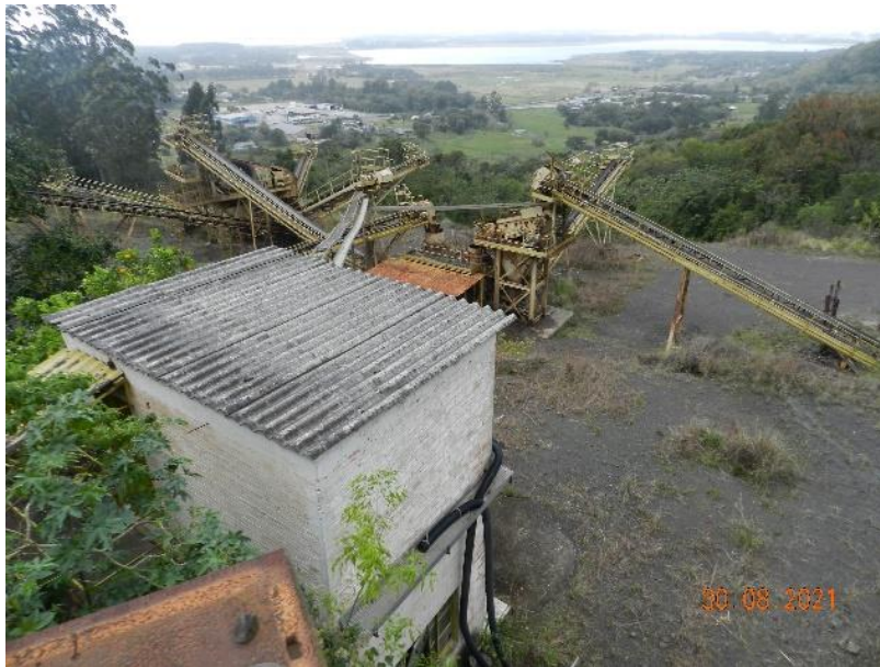
Figura 56 - Pedreira em recuperação judicial, estruturas da britagem.
