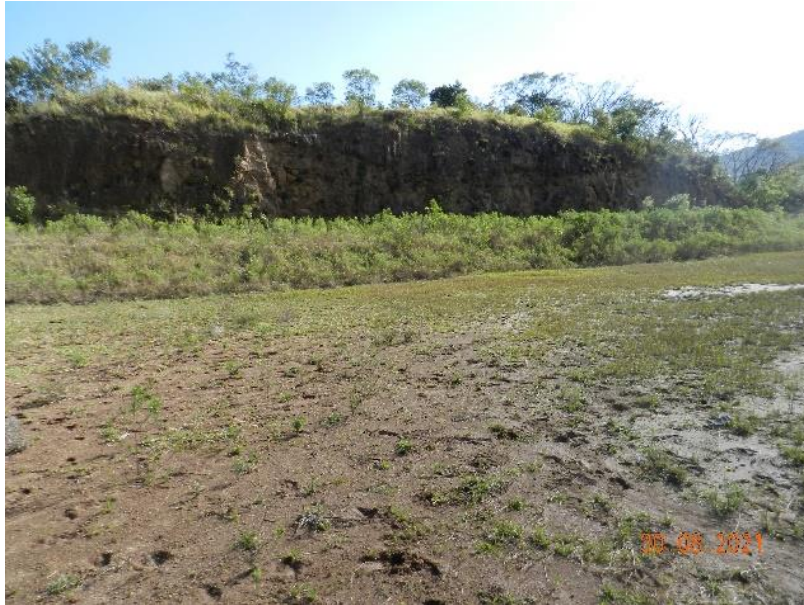
Figura 50 - Paredão ao fundo da terceira cava desativada.
