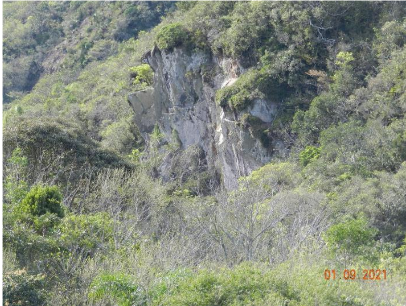
Figura 37 - Talude rochoso em talvegue de arroio.
