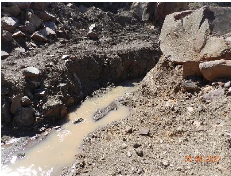
Figura 44 - Saída da água da cava
