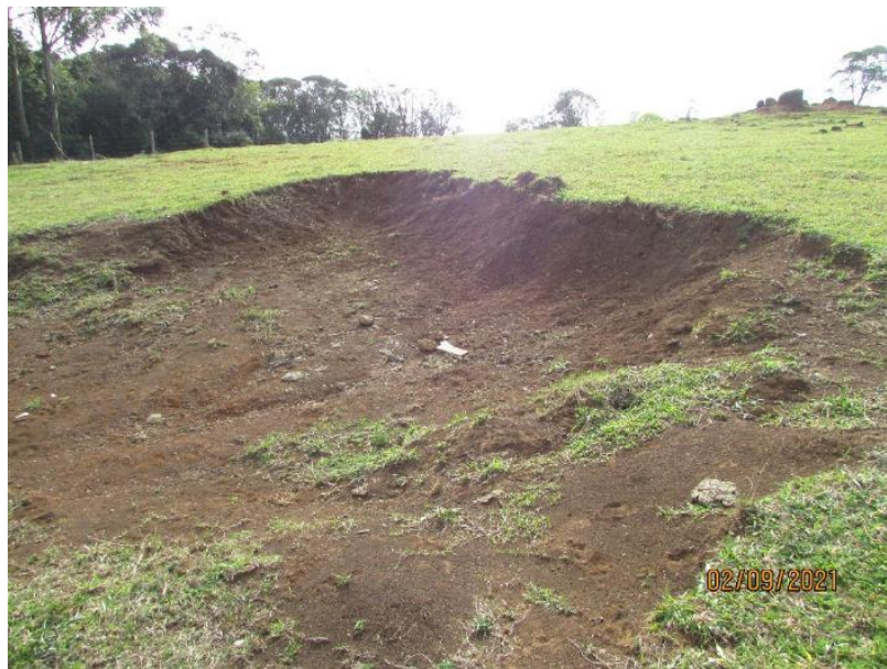
Figura 59 - Solo exposto em talude natural em meio ao campo.
