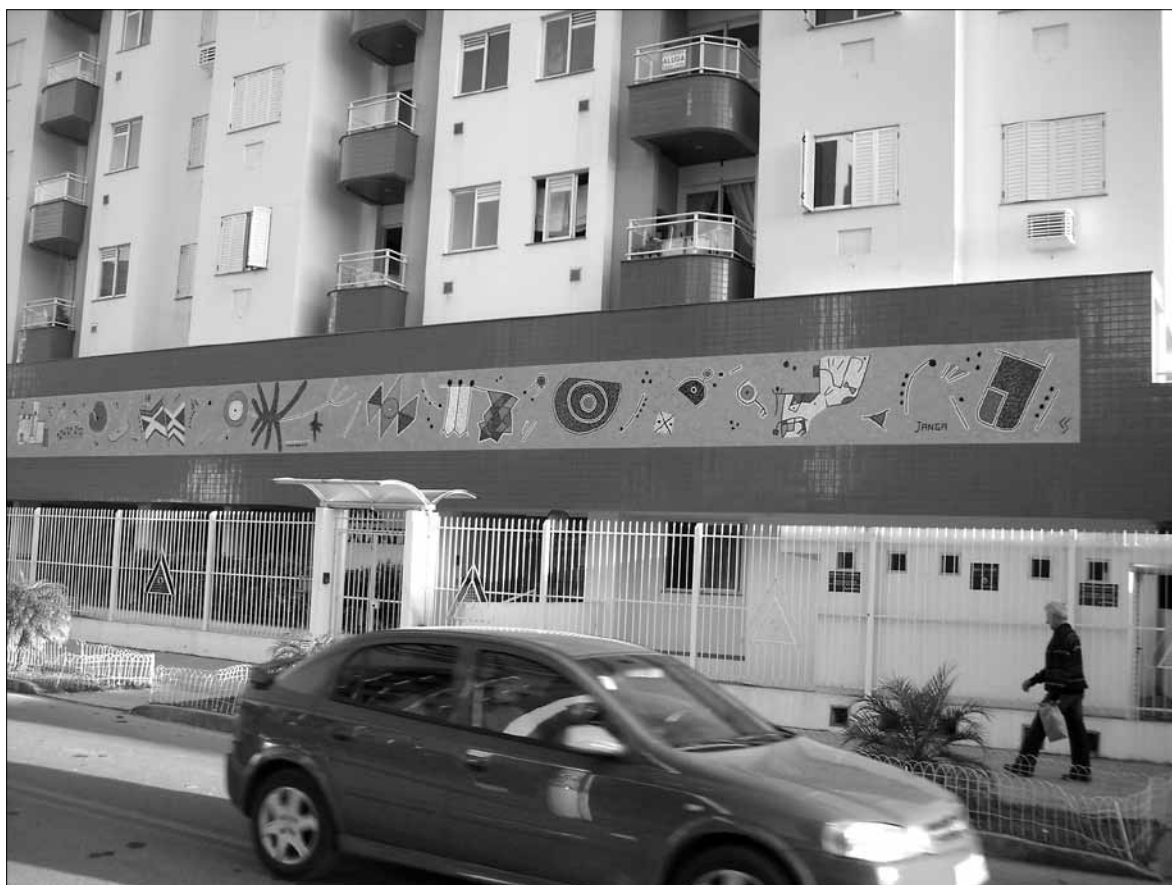
painel em fachada de edifício, Florianópolis. Janga (João Otávio Neves Filho)
