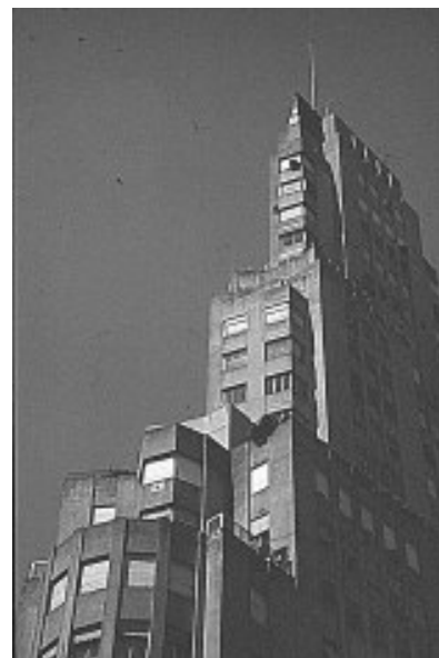
Edificio Kavanagh Sanchez, Lagos y de la Torre, 1935.
