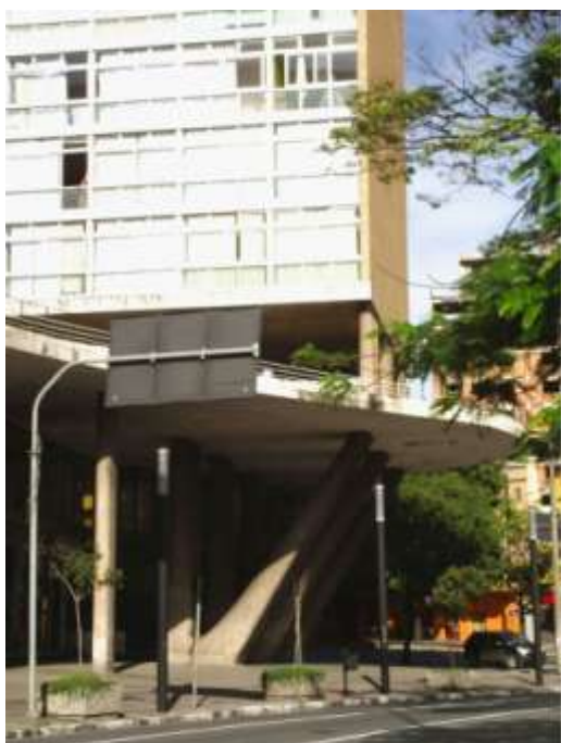
Figura 20: Pilares fazem transição em “V” na chegada ao solo.
