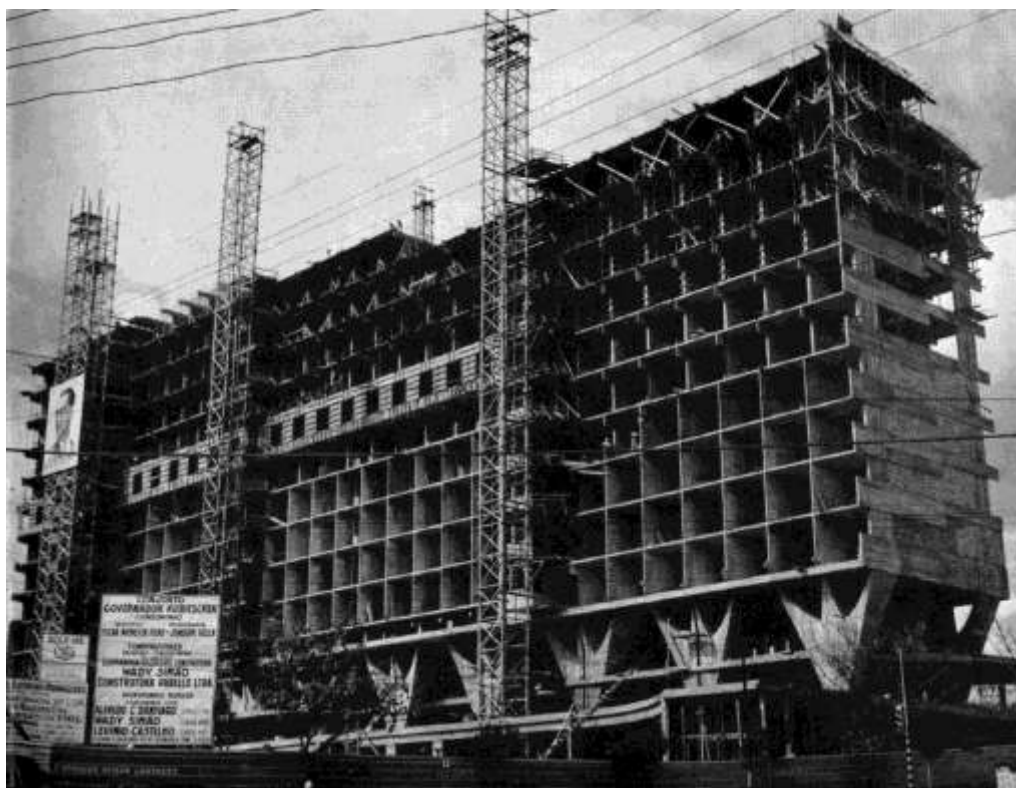
Figura 3: Foto da estrutura em construção do bloco A. PAPADAKI, 1956. p. 51.
