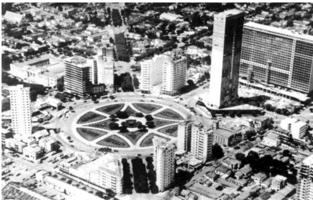
Figura 9: Vista aérea do conjunto JK em construção
