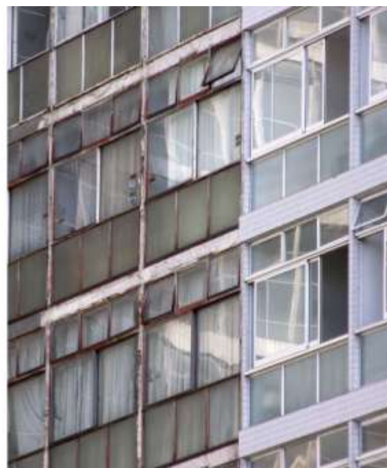
Figura 21: Esquadrias e revestimento sendo substituídos grosseiramente.
