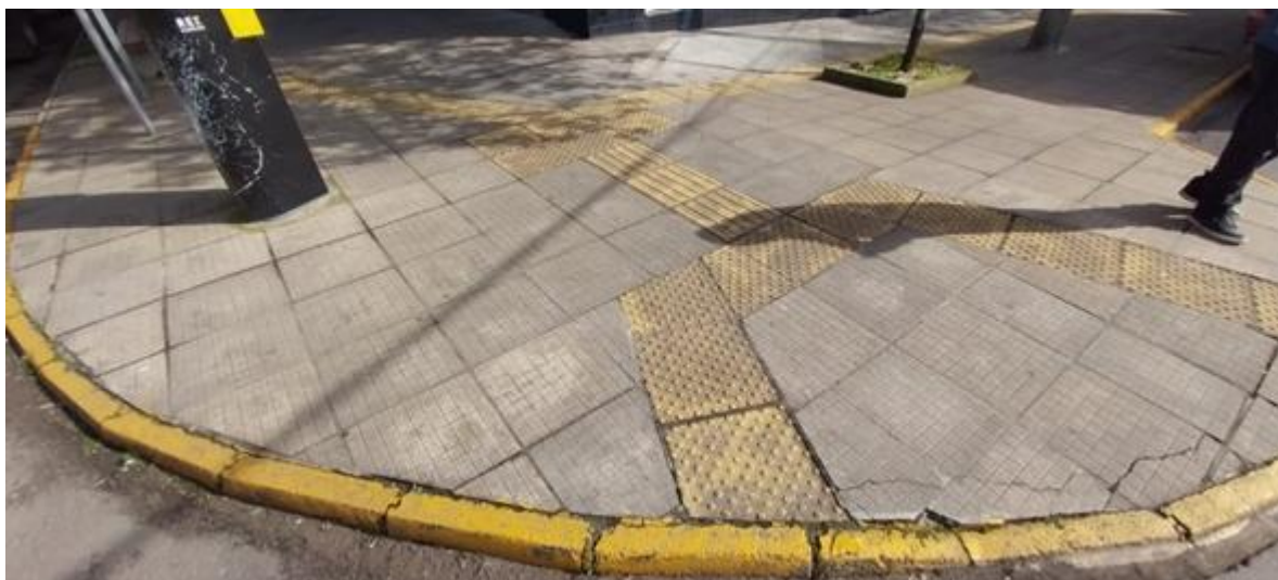
Piso tátil externo com rebaixamento da guia de meio-fio junto à travessia do semáforo da esquina. Foto: Guilherme Siqueira
