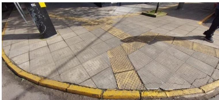
Piso tátil externo com rebaixamento da guia de meio-fio junto à travessia do semáforo da esquina.
